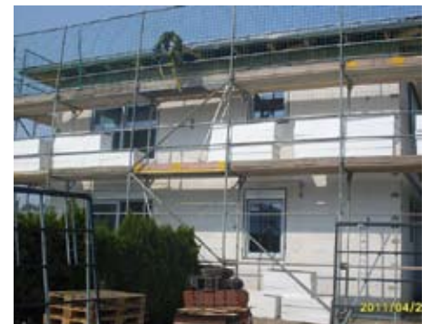
Foto: Aktueller Baustand des Objektes
